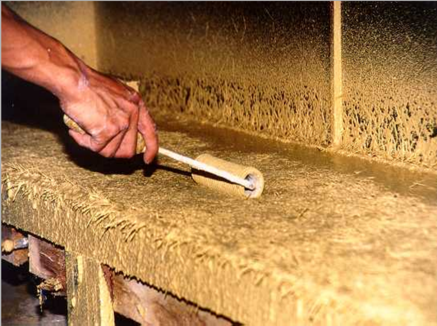
GRC结构层完成
