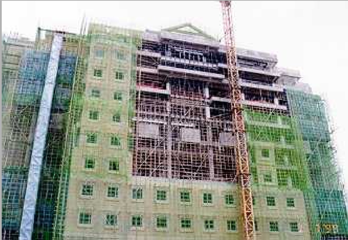
香港中央图书馆正面 装饰性GRC板装有结构钢架
