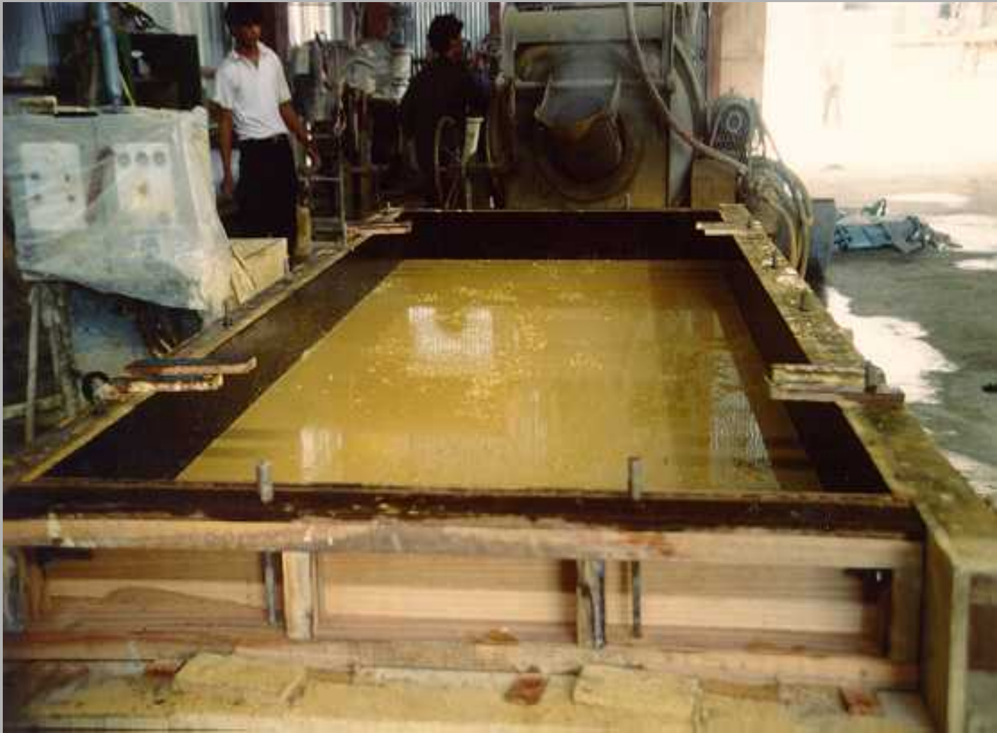
彩色混凝土面层完成
