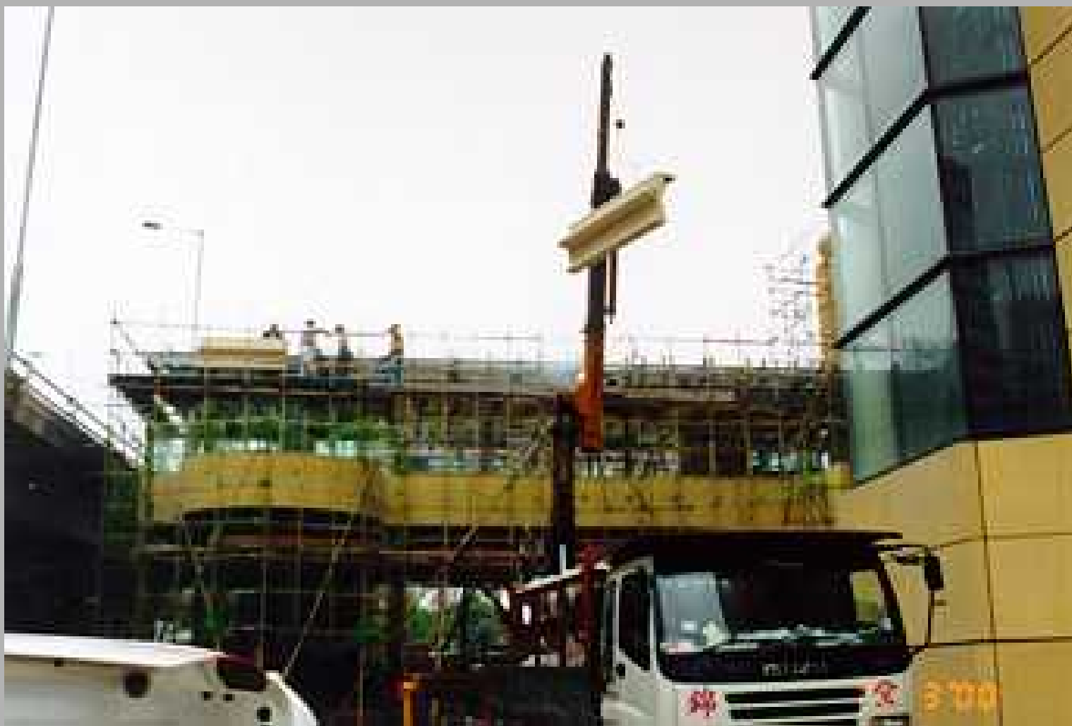
香港中央图书馆：安装中的GRC板(正面)
