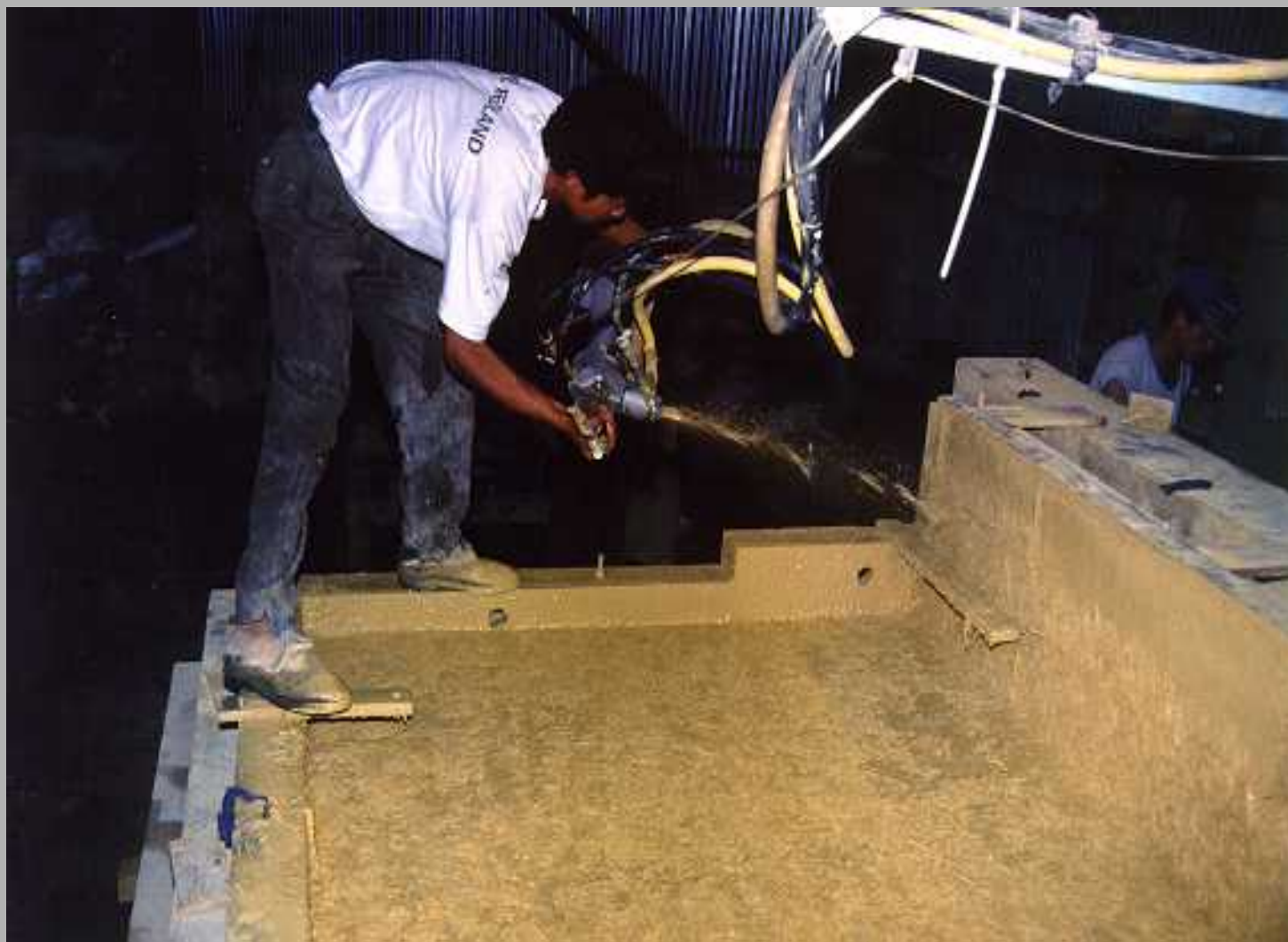
喷浆法制作GRC结构层
