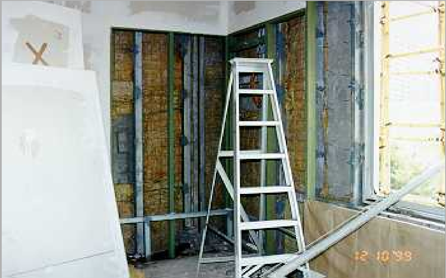
香港中央图书馆：安装中的GRC板（背面）
