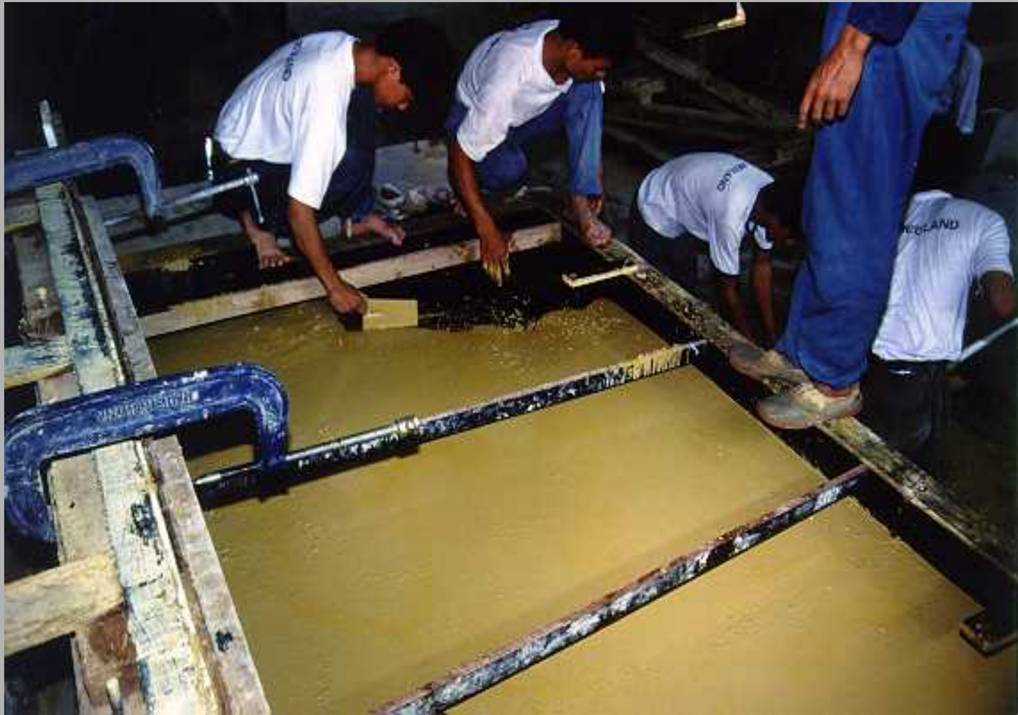
制作彩色混凝土面层
